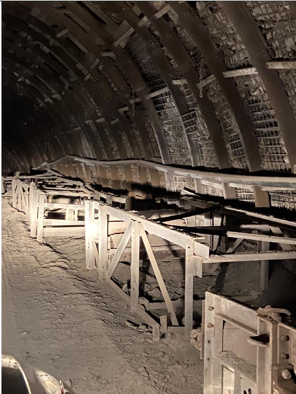
Foto 4 – Carpenteria nastro trasportatore
