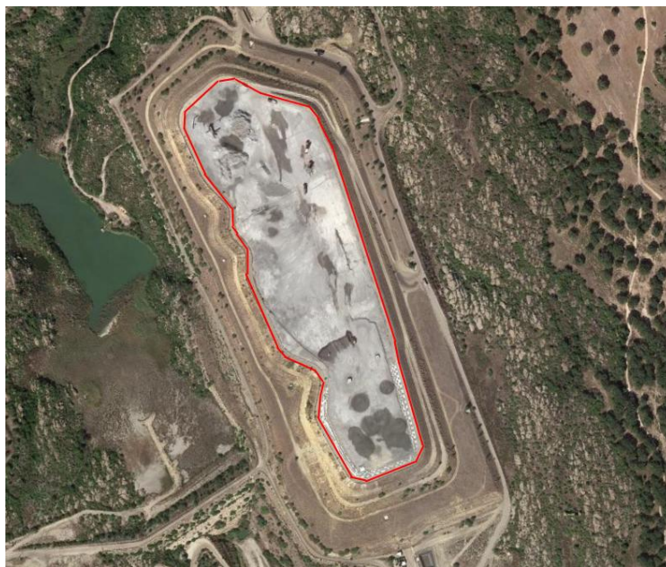
Fig. 1 – Discarica RNP Carbosulcis con indicazione dell'area interessata dall'attività di capping.
