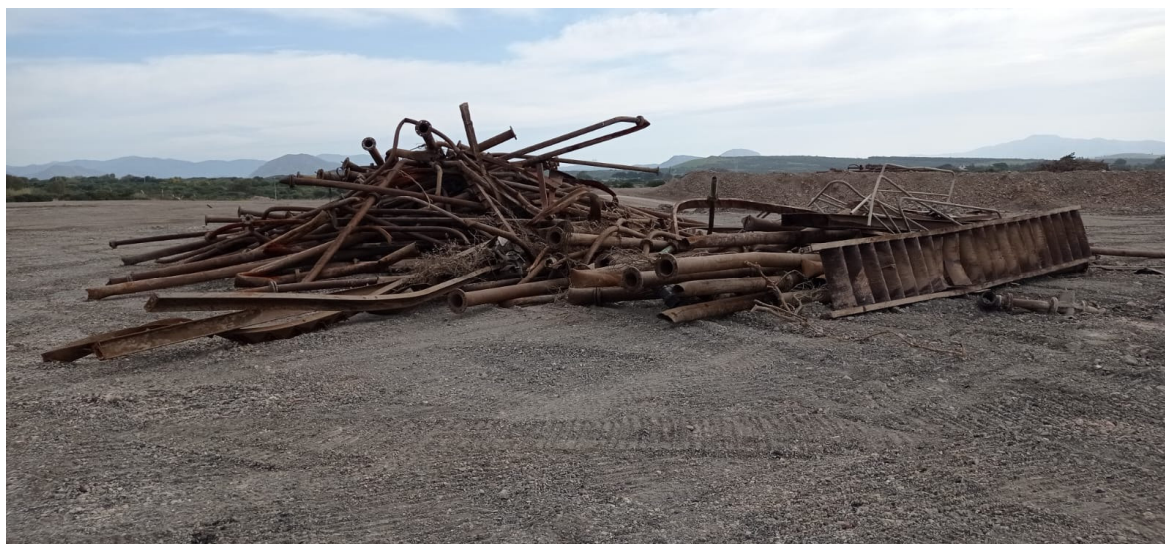
Foto 5 – Tubazioni e scale Seruci: peso complessivo circa 20 tonnellate
